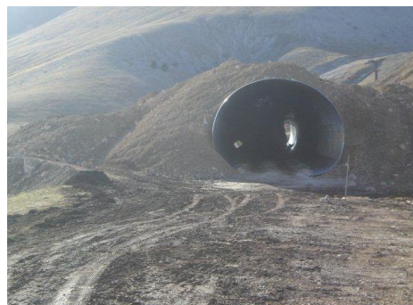
Installazione errata
